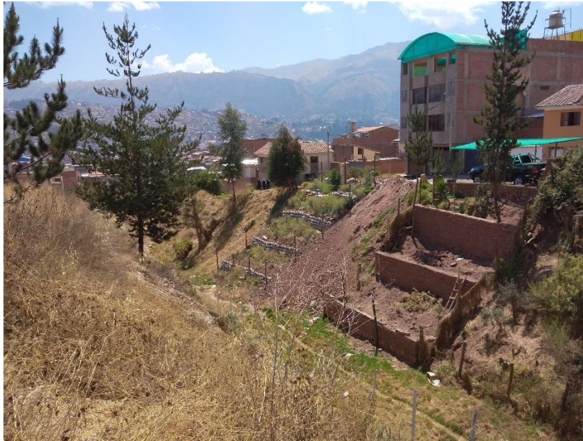
Imagen N 57: Vista de la parte media del ámbito de intervención de la ZRESS11-17
