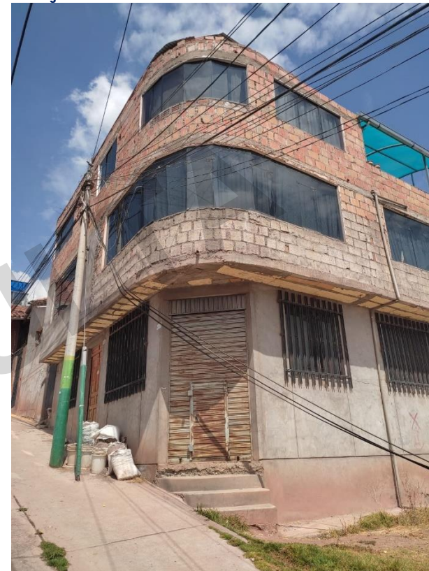
Imagen N° 39: Edificación en concreto armado en la A.P.V. UVIMA VII
