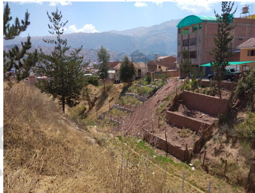
Imagen N 61: Vista parcial de una sección de la parte media de la quebrada Ccaramascara, se puede apreciar la disposición de escombros y las instalaciones ajenas al paisaje natural.
