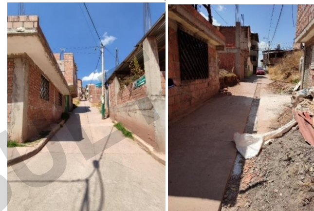
Imagen N° 47: Pasaje Wiraqochan. Vía que no cuenta con canales de evacuación de aguas pluviales y Pasaje Wanso. Canal de evacuación de aguas pluviales, obstaculizado por escombros
