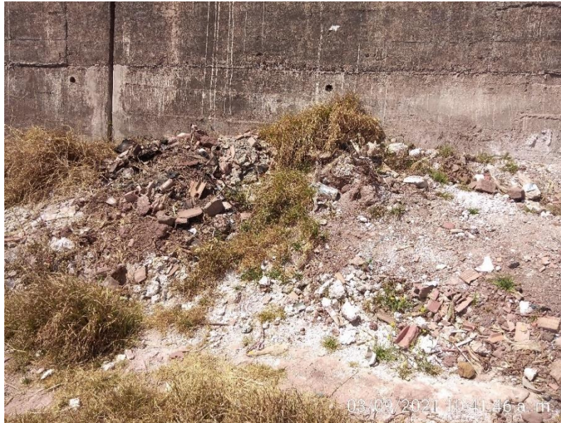
Imagen N° 75: Residuos sólidos parte alta del ámbito de intervención de la ZRESS11-17.
