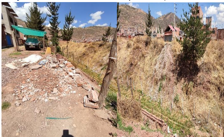
Imagen N° 46: Presencia de escombros en calles y ladera de la quebrada Ccaramascara
