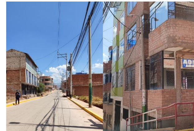
Imagen N° 44: Líneas de media y baja tensión, subestación ubicada en los postes de alumbrado público adosados a las edificaciones
