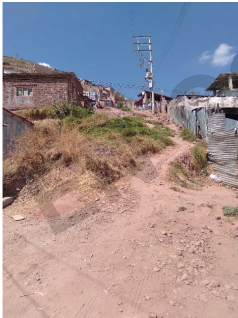
Imagen N° 20: Av. Qaramascara pendiente de 12 y 50%
