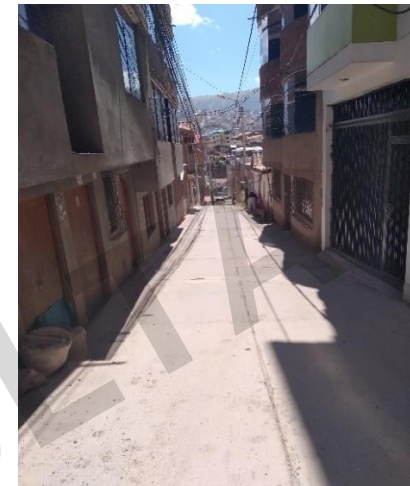
Imagen N° 23: Pasaje peatonal con uso vehicular Qoromiray estado de conservación regular
